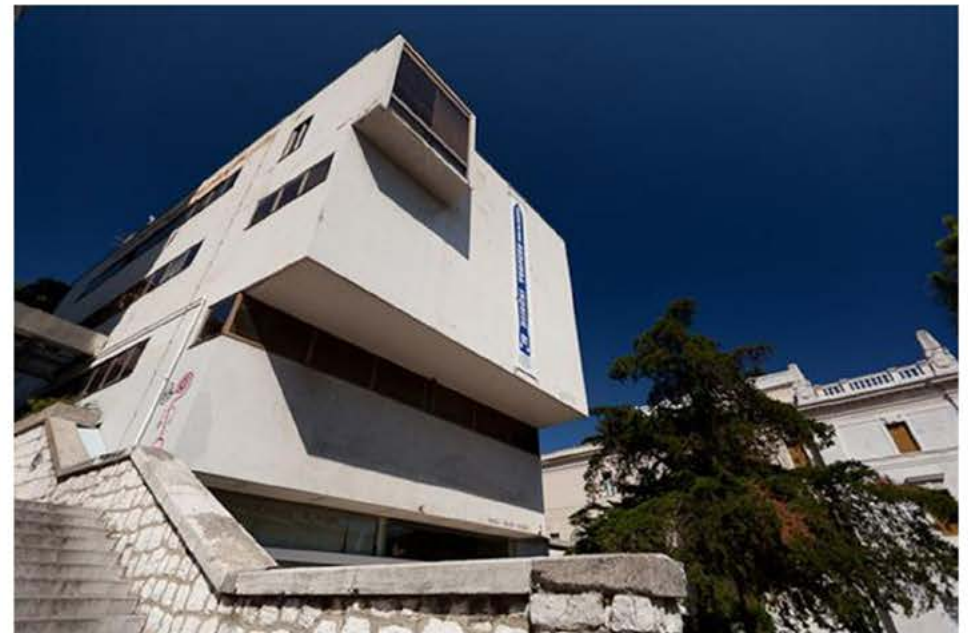
Muzeja grada Rijeke, pročelje ( http://www.visitrijeka.hr/Sto_vidjeti/Muzeji_i_zbirke/Muzej_grada_Rijeke , 3.12.2014.)
