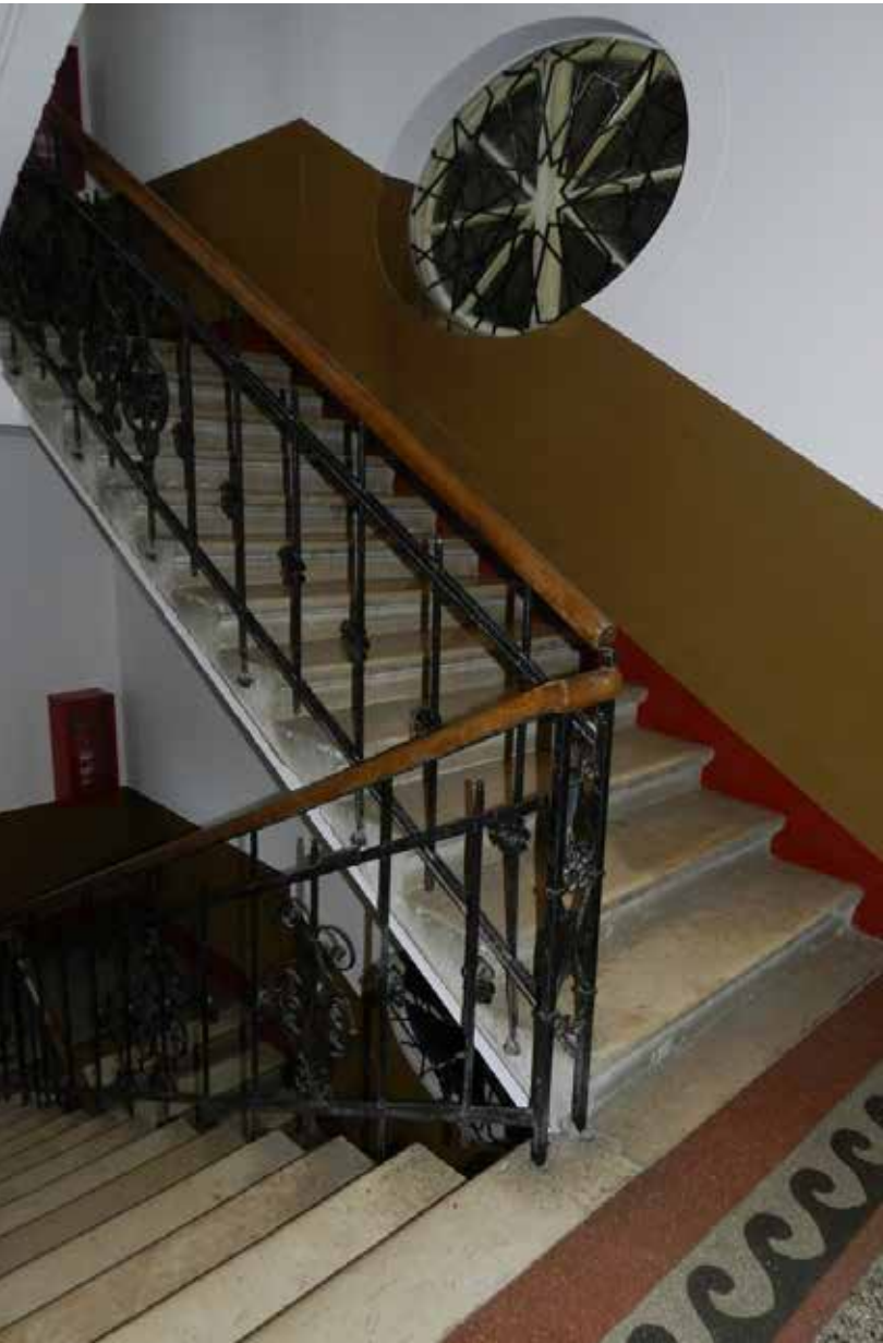
7 „Turska kuća“, Rijeka, stubište
