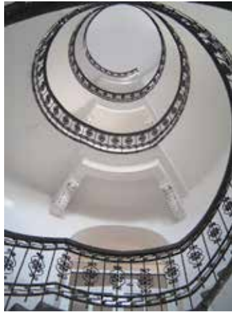
Slika 5: Ferenc Pfaff, Zgrade za činovnike željeznice, 1892. (foto Nana Palinić)
