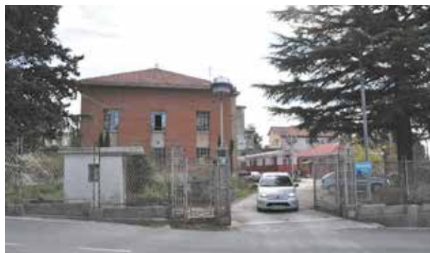
Slika 21: Elektrovučna podstanica u Matuljima izgrađena 1936. g. i očuvana kao spomenik industrijsko-tehničke kulture. (foto Orbanić 2012.)
