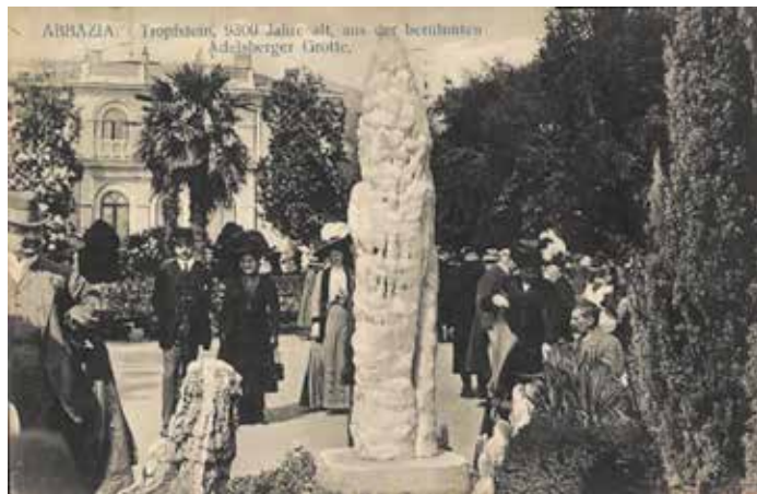
Slika 4: Razglednica s motivom Postojnskog stalagmita. S današnjeg gledišta, uništavanje unutrašnjosti jama, prijenos gotovo tisućljetnog stalagmita, nije dozvoljen, a tada je to predstavljalo atrakciju (zbirka Orbanić).
