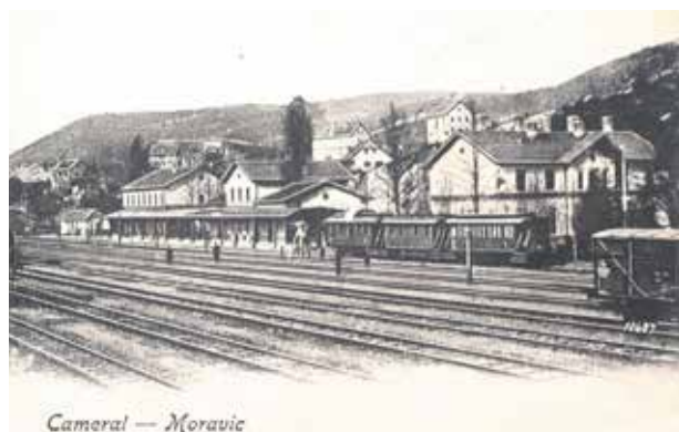
Slika 3: Dio kompleksa zgrada Mađarskih kraljevskih državnih željeznica u Moravicama u austro-ugarskom razdoblju (Razglednica s kraja 19. stoljeća. Izvor: http://www.vasutallomasok.hu/index.php?o=showlanc&l=5916&f=2021 , pristupljeno 17. 9. 2024.).
