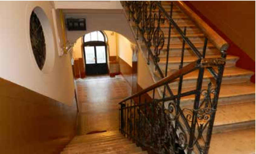
8 „Turska kuća“, Rijeka, stubište
