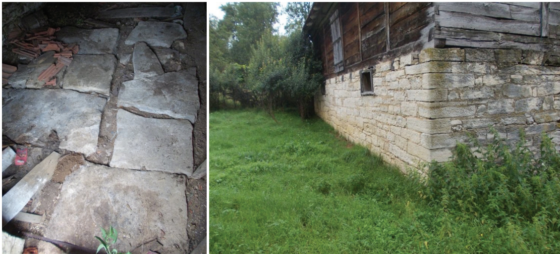
Slika 1 Štala napravljena od kamena i pod popločan nadgrobnim pločama sa lokaliteta Đurđevac
